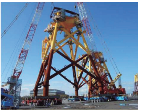
基礎(ジャケッット式) 於: 日鉄鋼構造(株)若松工場
